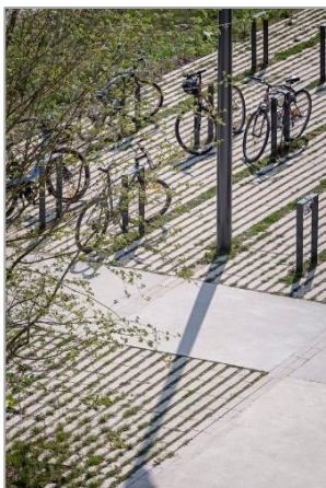
Stationnements vélo de type arceaux sur une surface perméable aux eaux pluviales
