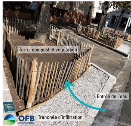
Principe de l'arbre de pluie.
