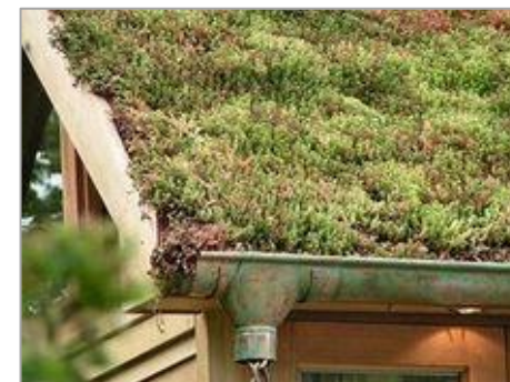
Toiture végétalisée extensive
