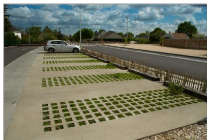
Béton coulé végétalisé en place
