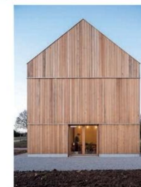
Référence d'une opération de densification par artificialisation à Gondenans-Montby (25) Maison G - Archidium - 2021
