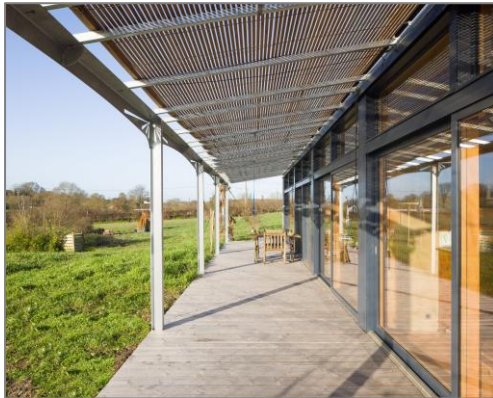
Maison individuelle passive : éclairage naturel, apports solaires des ouvertures vers le sud, protections solaires en période estivale. Elle offre également une forte inertie via la mise en œuvre de matériaux à forte capacité de stockage calorifique en sols (dalle béton, carrelage terre cuite) et en élévation (cloison de brique de terre crue, mur de pisé de 50 cm avec la terre issue du site) (Chaudefonds-sur-Layon (49)).
