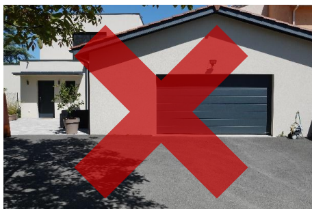
Illustration d'imperméabilisation par de l'enrobé à ne pas reproduire
