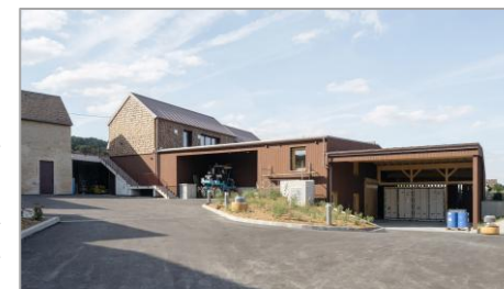
Intégration dans la pente d'une cuverie avec intégration de la partie bureaux/dégustation en façade sur la rue (2 photos en haut), et la partie hangar/caves dans la pente. Le revêtement enrobé noir dans la partie hangar n'est pas à reproduire (Chambolle-Musigny (21)). Source : CAUE.
