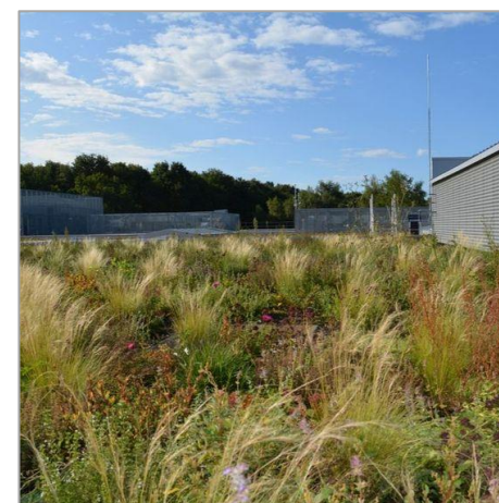
Toiture végétalisée semi-intensive
