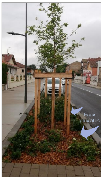
Tranchée de Stockholm
