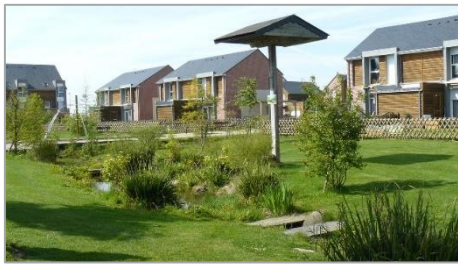
Bassin d'infiltration végétalisé
