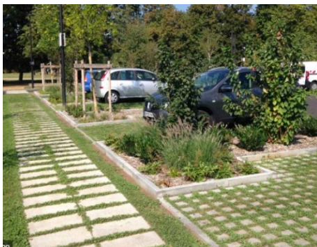
Chemin piéton et place de stationnement perméables aux eaux pluviales
