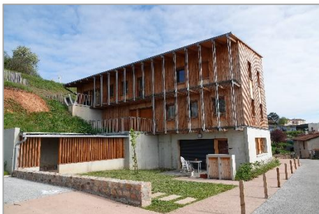
Construction d'un programme d'habitat en petit collectif et intermédiaire dans l'écoquartier de Meys. Source : CAUE.
