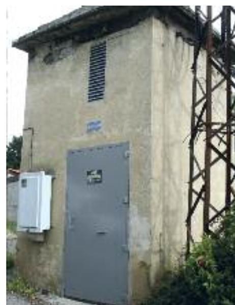
Le dernier "transfo" bâti en mâchefer et érigé en 1956 était devenu désuet. Sa structure externe et interne, détériorée par le temps, a conduit ENEDIS à le remplacer par un bloc positionné au sol sur le chemin du lavoir.
