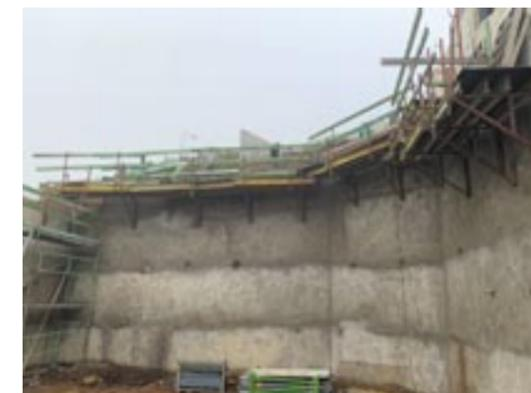
Cette technique particulière a été retenue pour réaliser le mur blindé, dans le but d'éviter le terrassement qu'aurait nécessité une technique traditionnelle avec des déblais et remblais très importants. Il n'y a pas de coffrage à réaliser et pas
