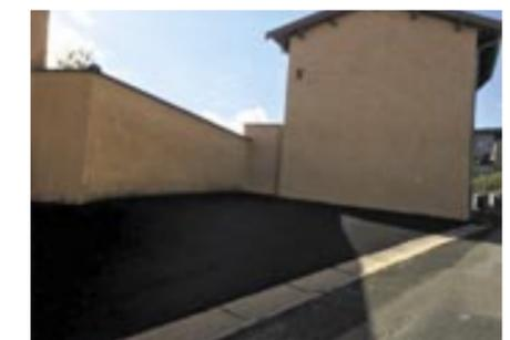
L'entreprise COLAS a donc refait l'enrobé de ce parking et canalisé l'eau pour qu'elle s'écoule dans le caniveau et non contre le mur et le bâtiment de la propriété riveraine. Ce chantier a été réalisé pour un montant de 3 366 €.
