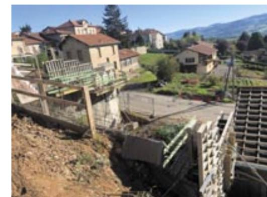
Ce travail consiste à faire un mur en béton armé, par étages, en commençant par le haut et en décaissant la terre de haut en bas, tout en réalisant ce mur au fur et à mesure de l'excavation des terres.
